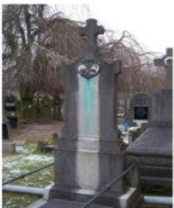
Koperpartikels uit het brons hebben enerzijds een reinigende en anti-mos werking, maar zorgen anderzijds voor een groen/turquoise verkleuring op de natuursteen die zeer moeilijk te verwijderen is.
