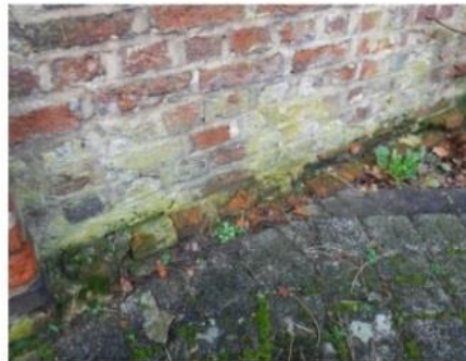
vochtinfiltraties naar blootliggend en beschadigd funderingsmetselwerk
